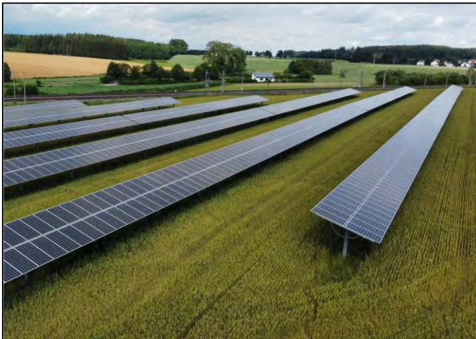
Abb.: Beispielfoto Trackeranlage (Quelle: Feldwerke GmbH)
