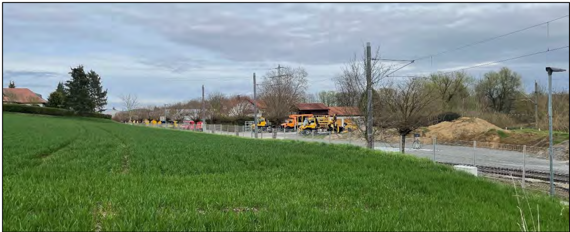
Abb.: Blick auf den westlichen Bereich des Firmengeländes
