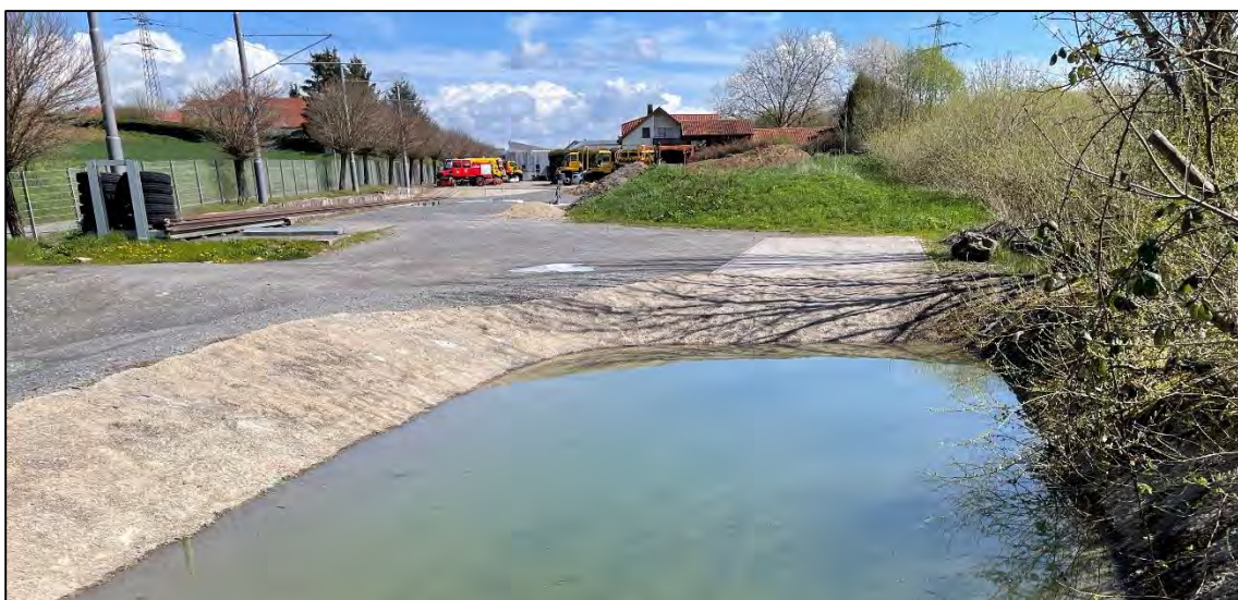
Abb.: Blick auf Betonbecken und den westlichen Bereich des Firmengeländes mit Bodenmieten
