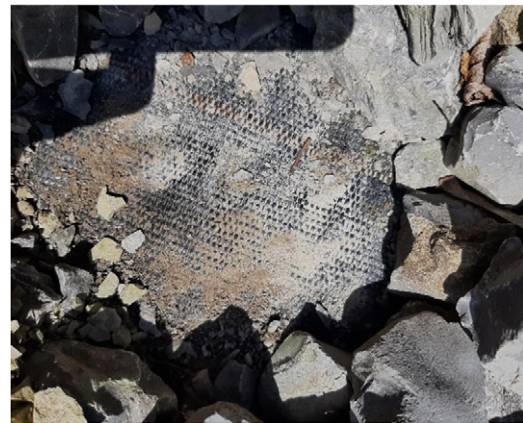
Abbildung 21: Unter dem Ziersplitt befindet sich ein Unkrautvlies (06.06.2024).
