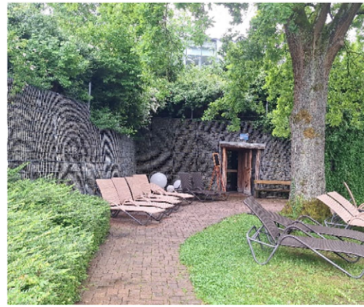
Abbildung 23: Die angrenzenden Vegetationsstrukturen führen zu einer Verschattung der Gabionen (24.05.2024).
