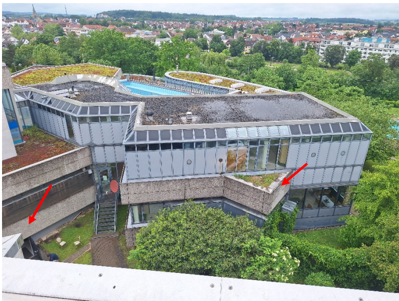
Abbildung 14: Dachbereiche des Hauptgebäudes
