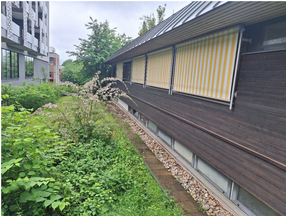
Abbildung 16: Afrikasauna II, Rückseite des Gebäudes
