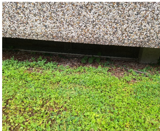
Abbildung 27: Der Kiesbereich unterhalb des Gebäudes wird beschattet (24.05.2024).
