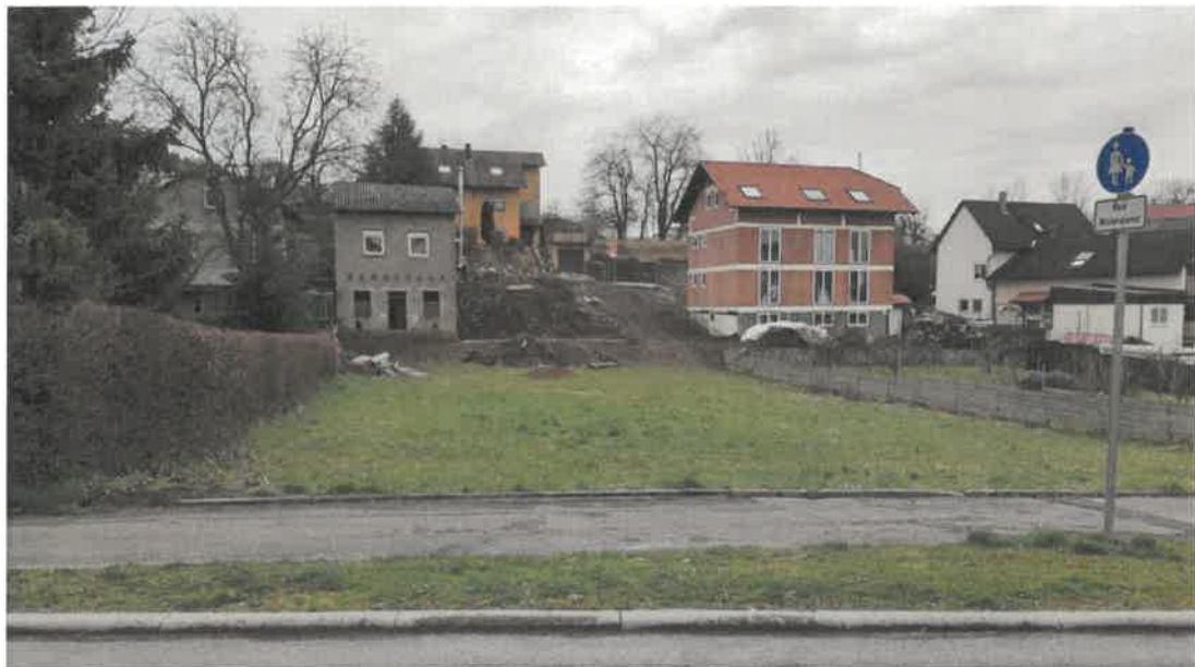
Abb. 4: Blick von Nordwesten (Talstraße) in Richtung Baugrundstück
