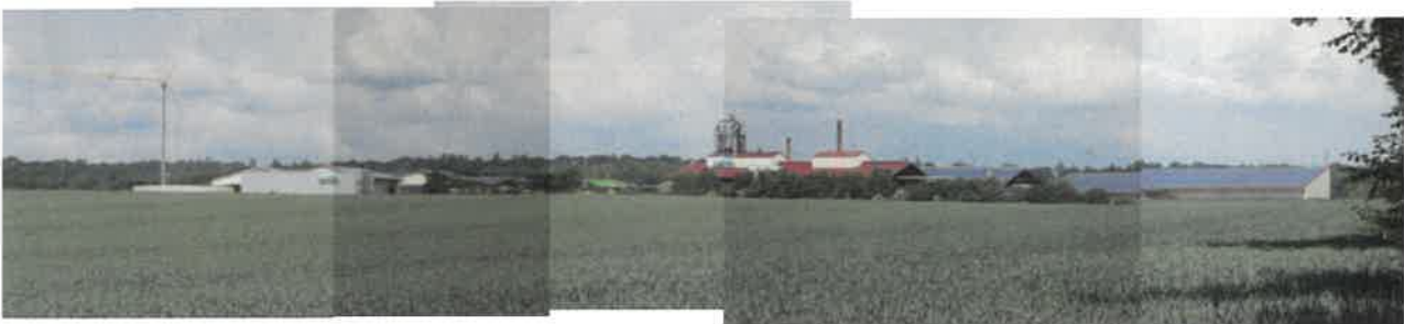
Abb. 13 Blick von Südosten auf das bestehende Betriebsgelände. Links beim Baukran der neueste Bauabschnitt der Abfall-Biogasanlage (Eingrünung in Entwicklung). Einzelne Bauteile wie die Schornsteine und die Abluftreinigung überschreiten die Gebäudehöhen punktuell.
