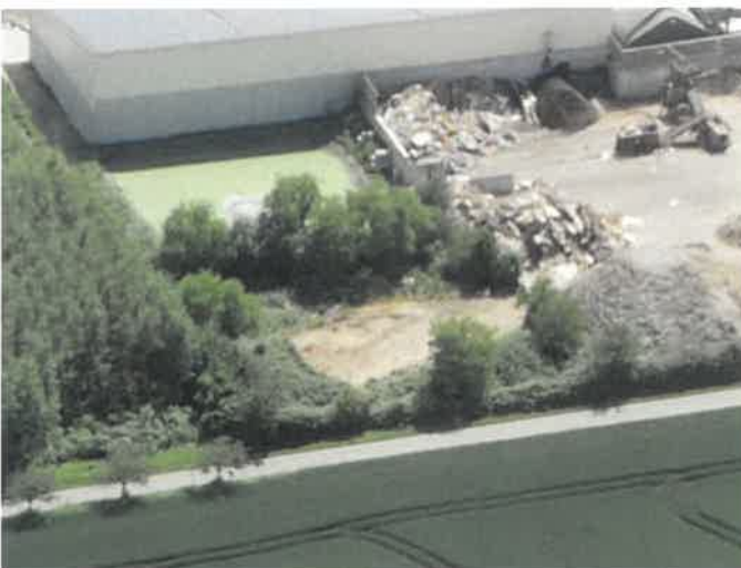
Abb. 10 Unbefestigte Lagerfläche und Rückhaltebecken
