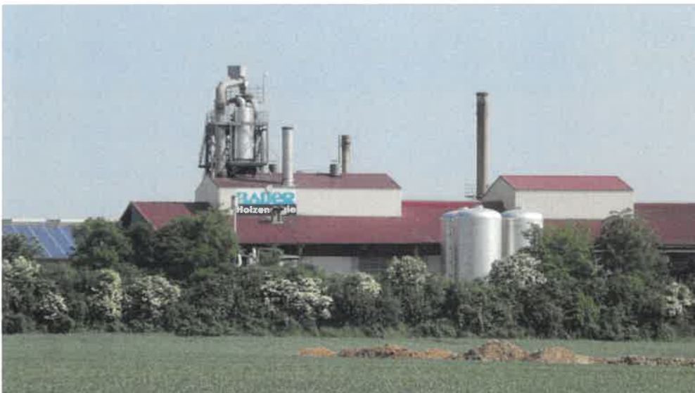
Abb.1 Bestehende Werbeanlage der Fa. Bauer Kompost am Heizkraftwerk
