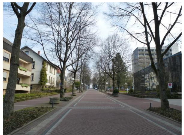
Abb. 5: Salinenstraße mit alleenartigem Baumbestand im Bereich des Plangebiets
